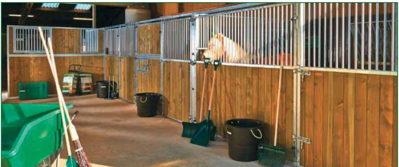
Estructura modular en acero galvanizado en caliente y madera de pino.
