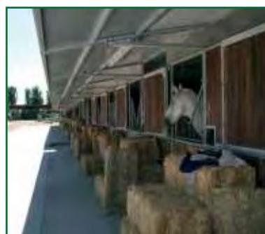
Detalle de alero con estructura de cubierta vista
